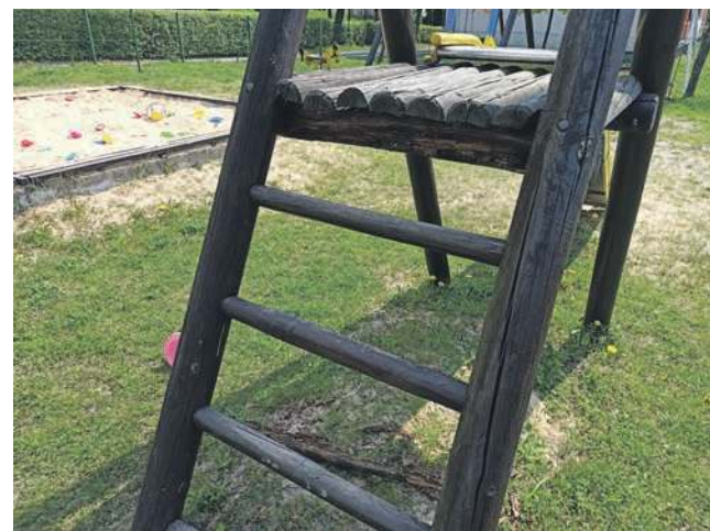
Ostre, wylamane elementy konstrukcji leżą pod zjeżdżalnią na placu zabaw przy ul. 1 Maja w Trzebini
