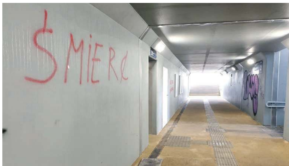
Przejście podziemne na stacji Chrzanów ul. Fabryczna
