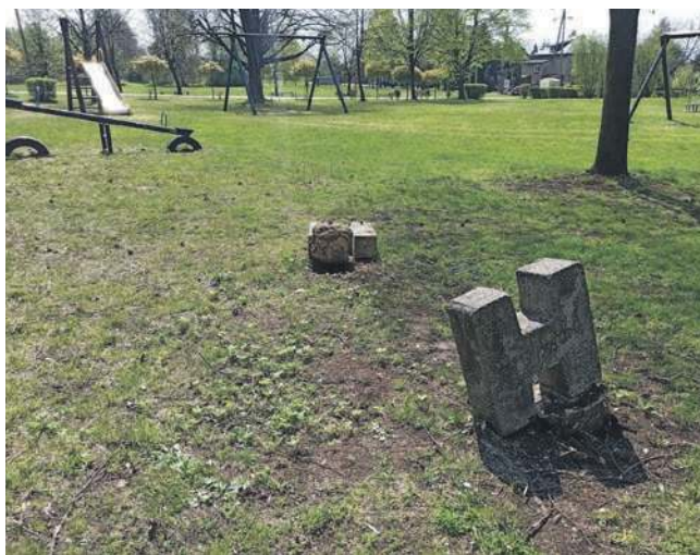
Zdewastowane miejsce zabaw przy ul. Styczniowej w Trzebini
