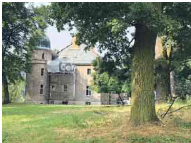
Pałac jest remontowany
