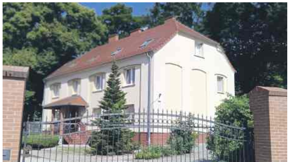
Dawna oficyna przy pałacu.
