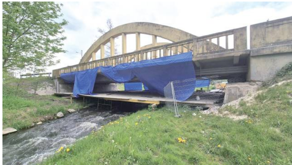
Most przy ulicy Lubelskiej w Biłgoraju będzie zamknięty na trzy-cztery miesiące
