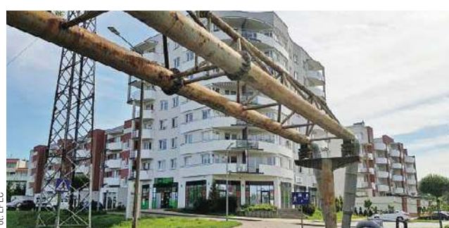
W Elblągu trwa modernizacja sieci ciepłowniczej
