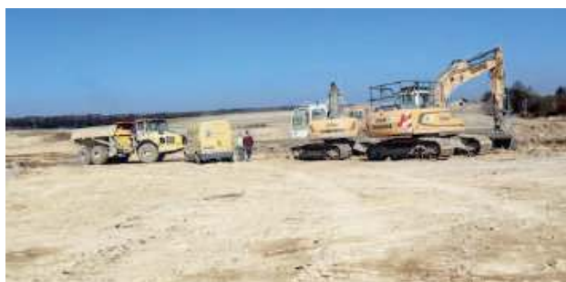
Obecnie prowadzone są roboty rozbiórkowe i ziemne
