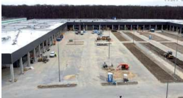
Prace na budowie nowego centrum handlowego dobiegają końca. Otwarcie Parku Handlowego Karuzela zaplanowano wstępnie na koniec kwietnia
