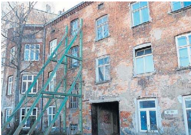
Ściany trzymają się dzięki olbrzymim podporom z metalu i drewna
