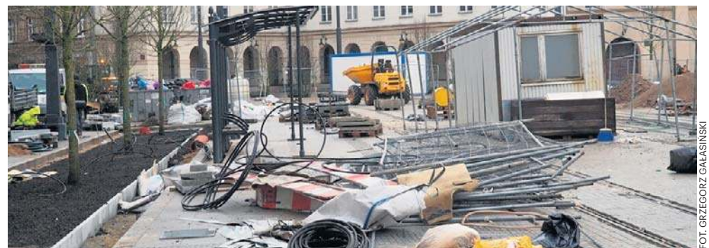
Prace na pl. Wolności w Łodzi potrwać jeszcze kilka tygodni. Z powodu poślizgu wykonawca ma ponieść kary finansowe
