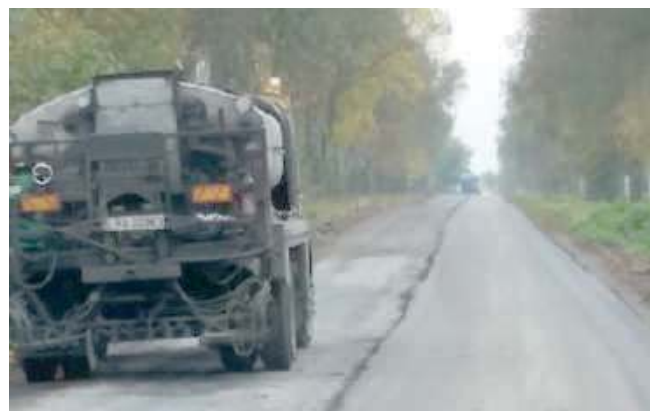
Całkowita wartość inwestycji to 8 351 449,01 zł
