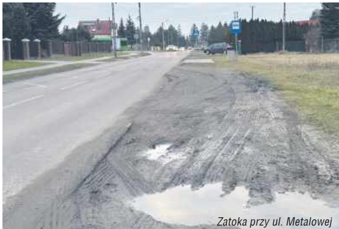
Zatoka przy ul. Metalowej
