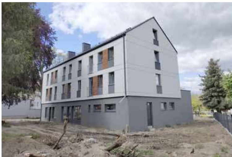
Budynek już wykończony, prace nad wykończeniem w trakcie
