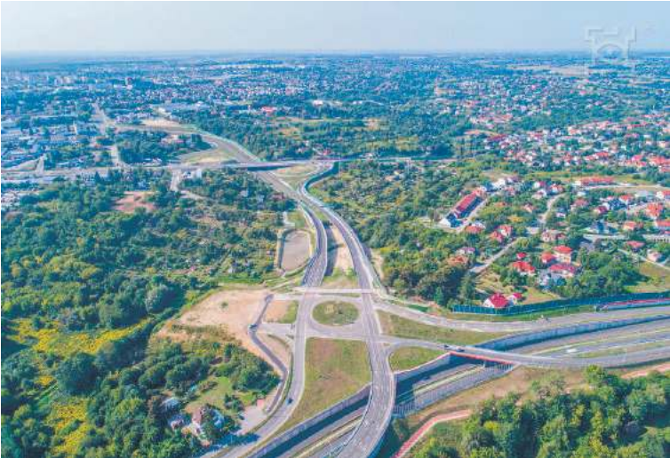
Budowa przedłużenia ulicy Bohaterów Monte Cassino kosztowała blisko 88 mln złotych. Droga została oddana do użytku pod koniec lipca ubiegłego roku, z trzymiesięcznym opóźnieniem
