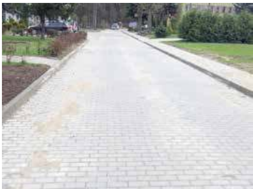
Droga już gotowa
