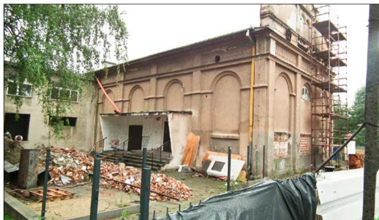
Jeszcze przed remontem. A właściwie w jego trakcie.
