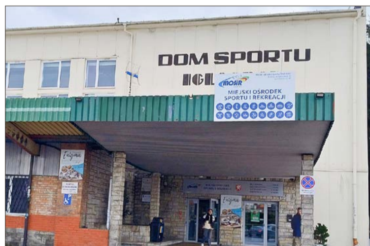
Miasto otrzyma prawie 1 mln zł na prace remontowe w Domu Sportu.
