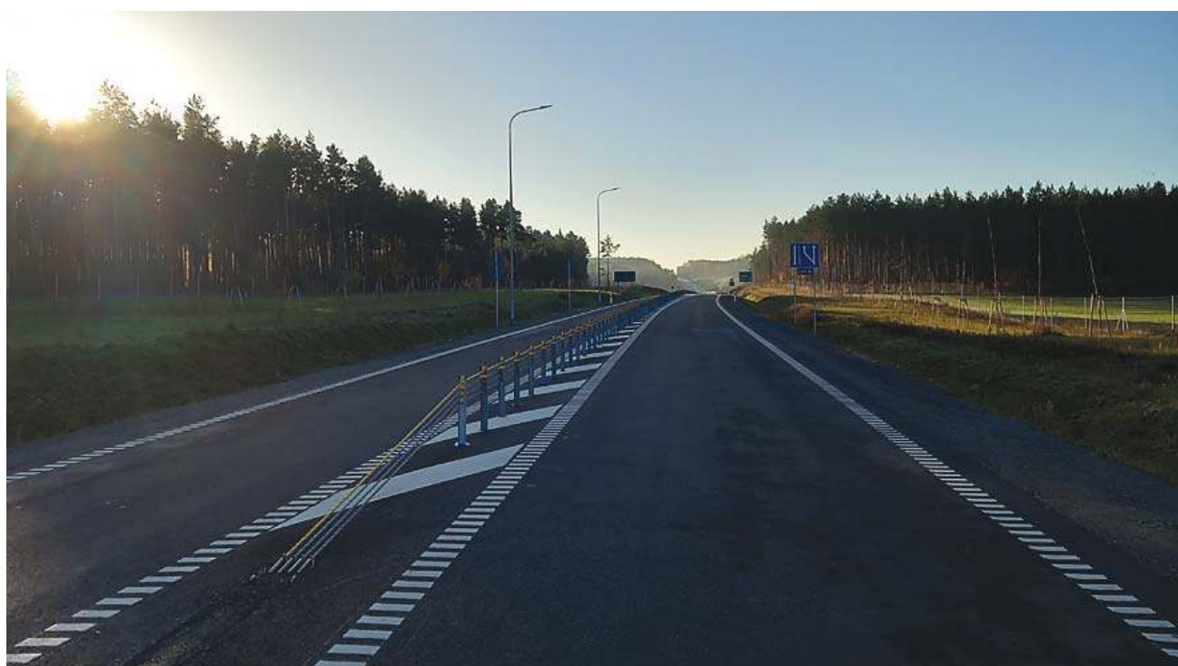
W ubiegłym roku została oddana do użytku obwodnica Nowego Miasta Lubawskiego w ciągu DK15
