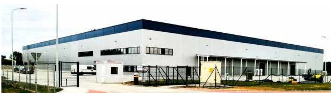
W Parku Przemysłowym Nowoczesnych Technologii wybudowano drugą halę firmy Hydrolina. Hala ma pow. 13.000 m2.
