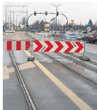
Prace będą prowadzone na odcinku od ul. Dolnej do ul. Inflanckiej
