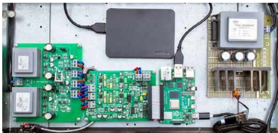
Fotografia 5. Wszystkie moduły odtwarzacza zamontowane w obudowie
