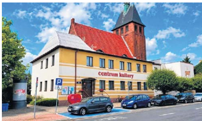
Budynek Centrum Kultury w Wielichowie przed prace remontowe związane z poprawą jego efektywności energetycznej
