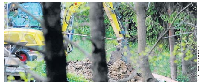
Mężczyzna wykonywał prace ziemne na swojej posesji
