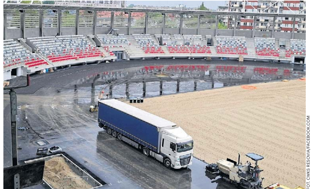
Budowa stadionu przy ul. Wyspiańskiego wzbudza ogromne zainteresowanie, szczególnie wśród kibiców
