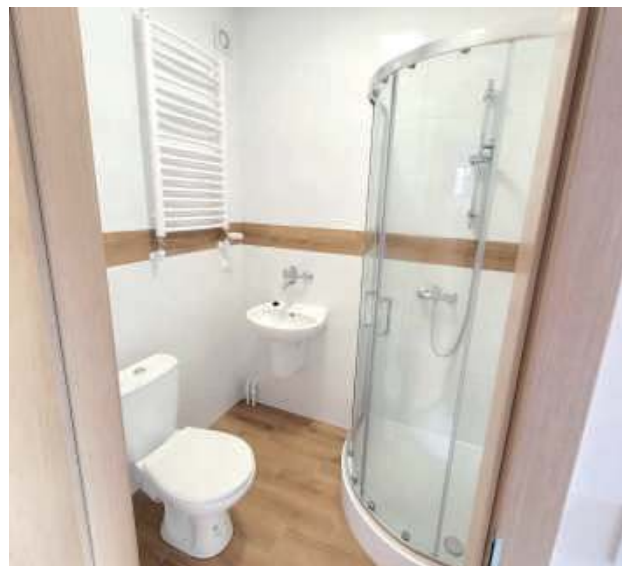
Łazienki przeszły gruntowny remont
