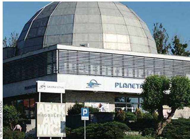
Remont planetarium zostanie przeprowadzony zgodnie z wytycznymi konserwatora zabytków
