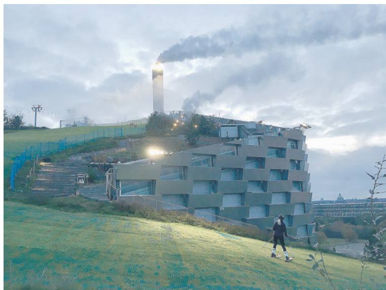
Kopenhaska spalarnia odpadów
