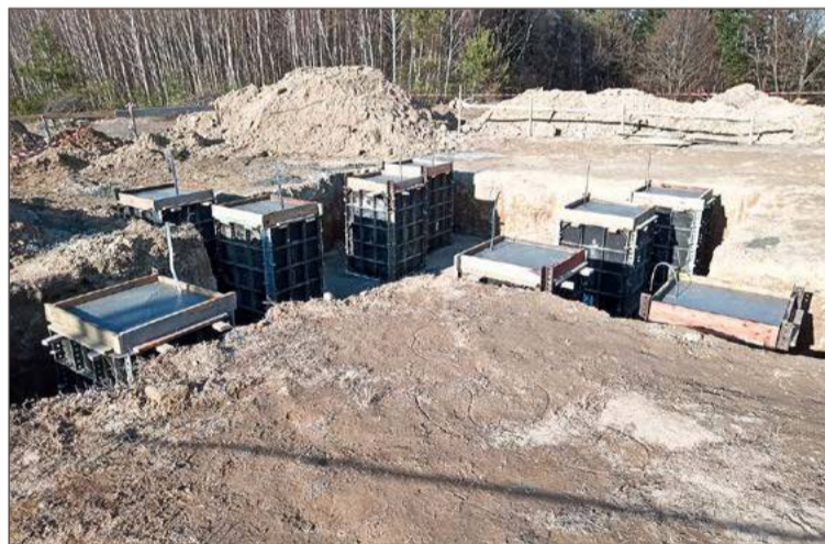
Fundamenty pod wieżę widokową w Wisowej już są gotowe.
