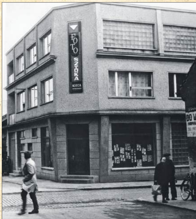
■ Zdjęcie budynku przy ul. Księżnej Konstancji 5
