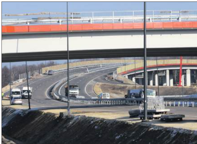
■ Od 13 września przejezdny będzie kolejny fragment drogi Racibórz–Pszczyna w Rybniku.
