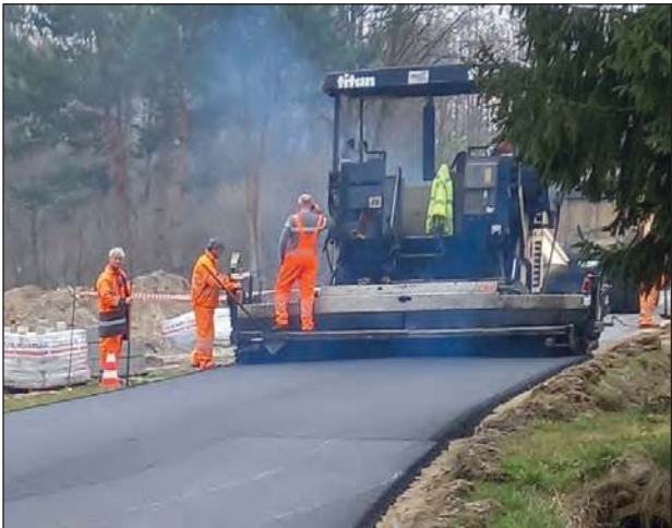
Prace przy modernizacji dróg trwały około miesiąca. Dzięki pomocy rządu, samorząd Nowodworu wykonał ponad 10 km nowych nawierzchni bitumicznych (fot. Gmina Nowodwór)
