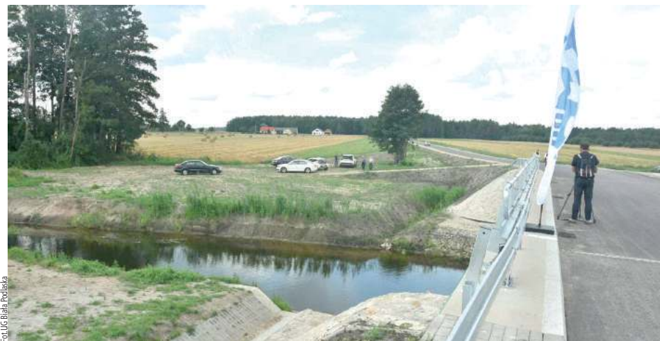
Nowy most to solidna konstrukcja, mogą nią przejeżdżać pojazdy nawet powyżej 50 ton nośności
