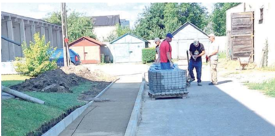
Trwa budowa chodnika przy ul. Piłsudskiego (dawna weterynaria)
