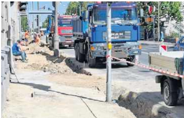
Modernizacja ulicy 25 Czerwca rozpoczęła się od demontażu chodnika od zachodniej części jezdni.
