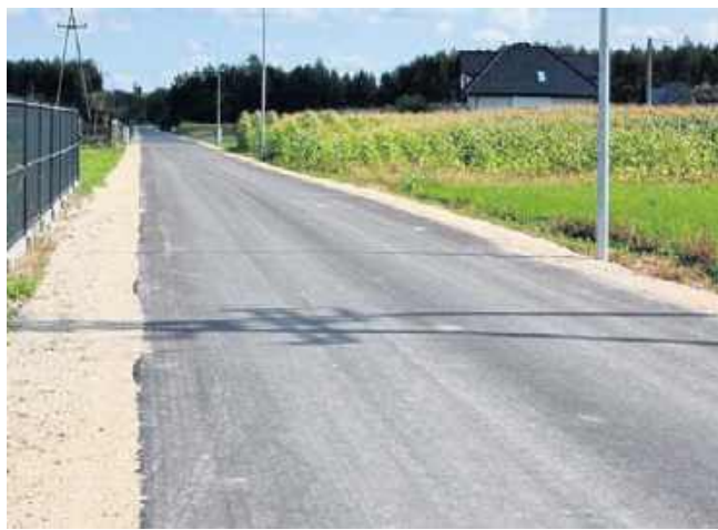
W Drochowie Dolnym w gminie Morawica oddano do użytku przebudowaną ulicę Bajeczną
