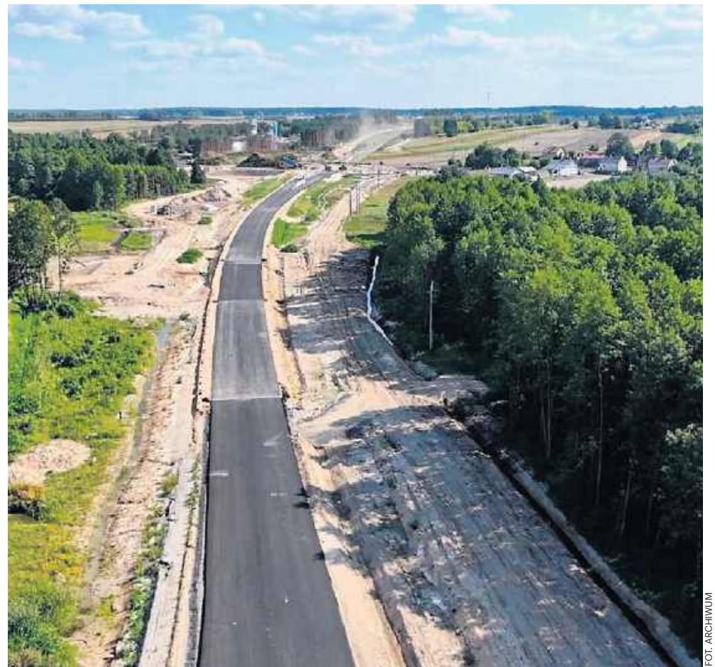
FOT. ARCHIWUM Budowa obwodnicy Ciepeliowa. Powstają kolejne fragmenty nowej trasy i skrzyżowania.
