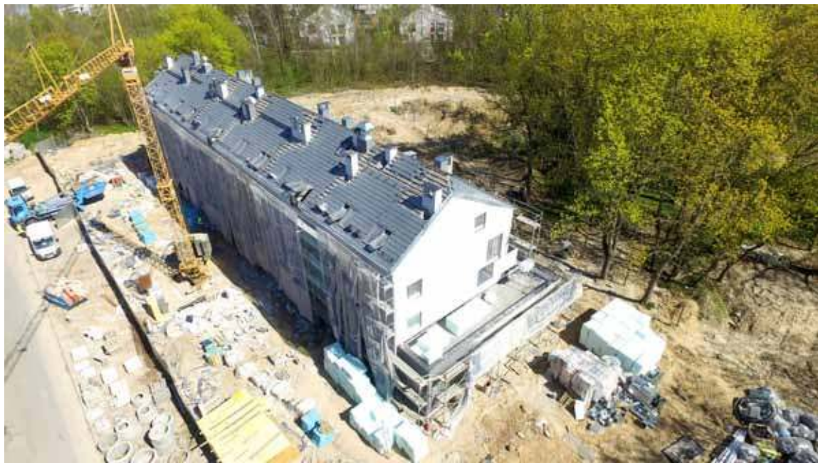
Dobiega końca budowa budynku mieszkalnego przy ul. Śniadeckiego. Można składać wnioski o zamianę mieszkania
