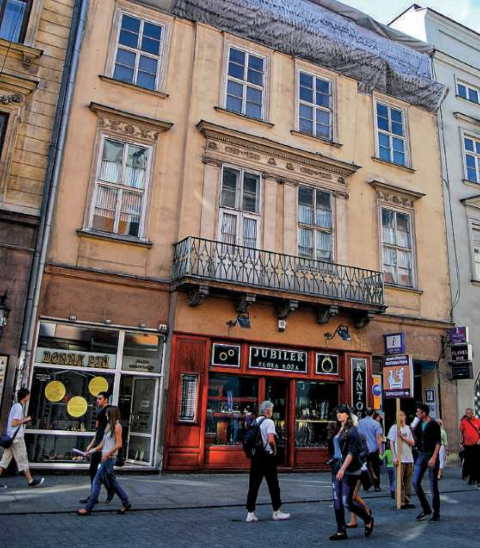
Krakowska XIX-wieczna „Kamienica pod okiem Opatrzności”, mieszcząca się tuż przy głównym rynku Starego Miasta, to prawdziwa perła w imperium biznesowym Koźmińskiego.
