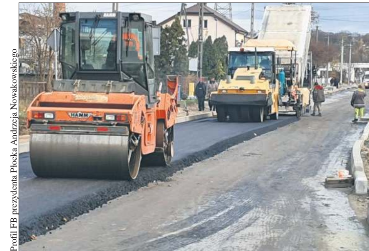
Układanie asfaltu na ulicy Kolejowej
