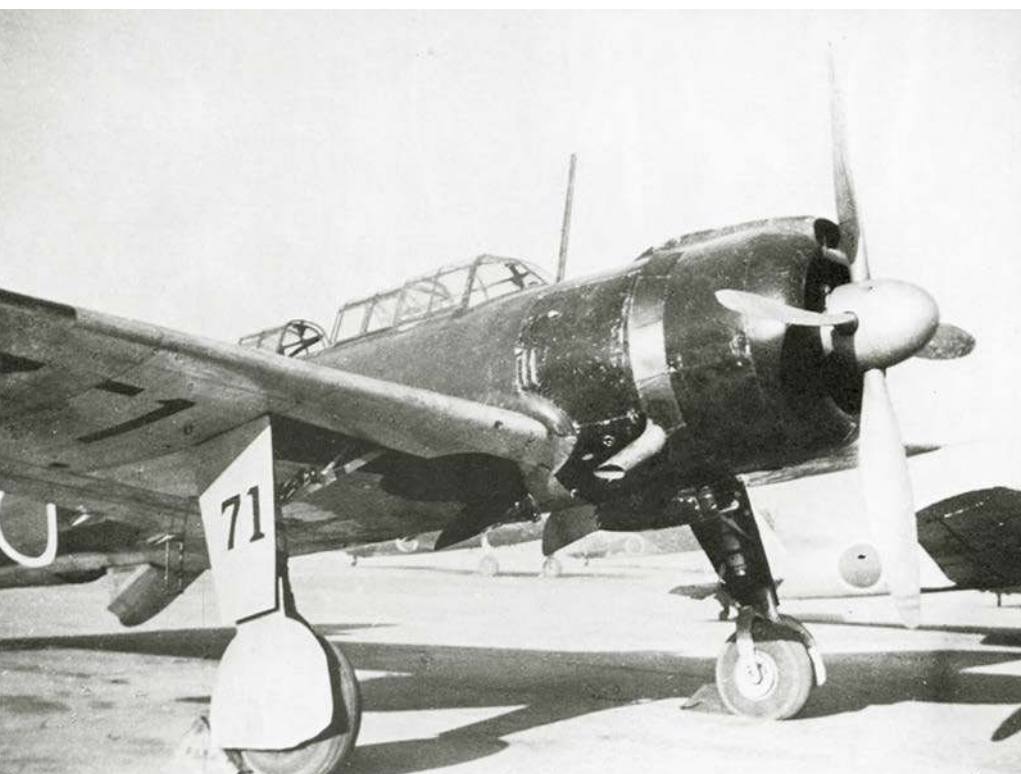
Seryjny B6N1 z Hyakurihara Kōkūtai. Samoloty tej wersji były napędzane silnikiem Nakajima Mamori 11, który okazał się jednak nieudany. Pod środkową częścią kadłuba widać wychyloną ławetę ruchomego karabinu maszynowego Typ 92 Modyfikacja 1 kal. 7,7 mm.
