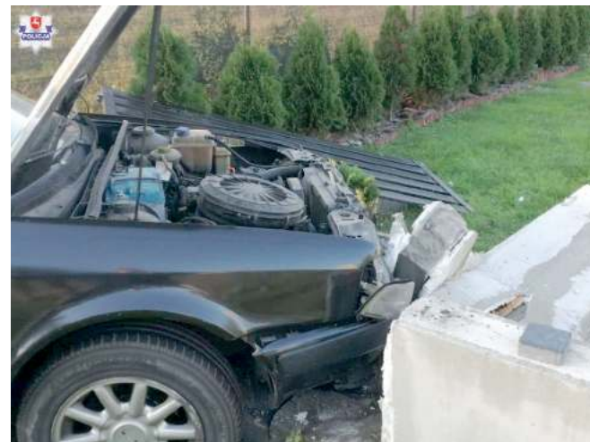
Auto uderzając z impetem w betonową podmurówkę ogrodzenia uszkodziło dwa metalowe przęsła o długości 8 metrów
