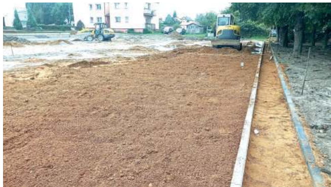
Prace na boisku już się zaczęły, a ich zakończenie jest planowane na koniec października. Wykonawcą jest przedsiębiorstwo Activa z Łodzi
