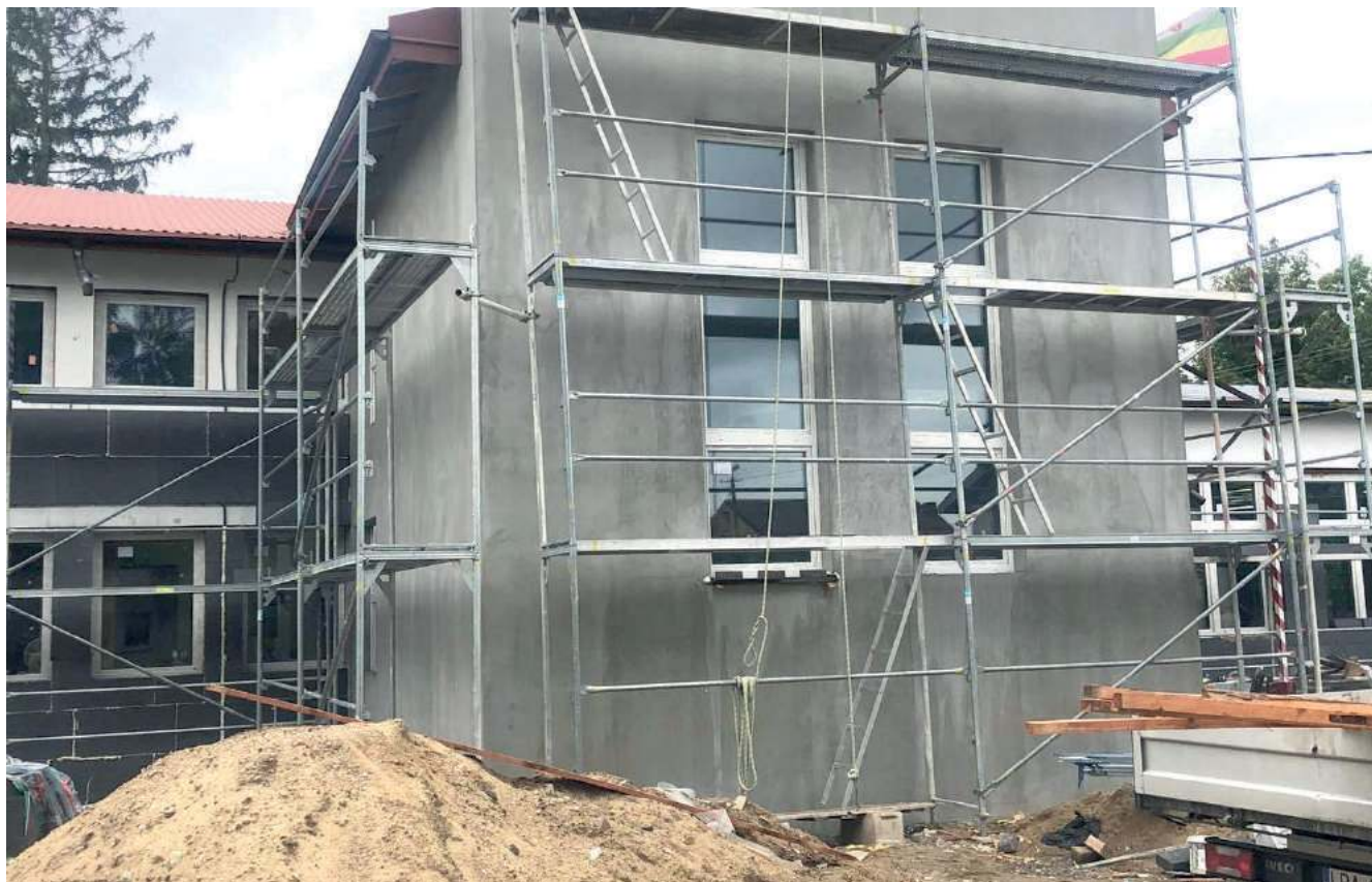
Tak jeszcze niedawno wyglądał z zewnątrz Urząd Gminy w Dębowej Kłodzie. Teraz prace dobiegają końca - trwa jeszcze wymiana instalacji elektrycznej i centralnego ogrzewania na dole budynku
