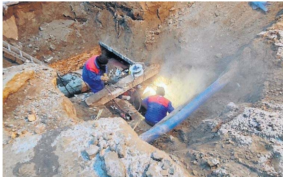
Ekipy remontowe MPEC pracowały nad usunięciem awarii
