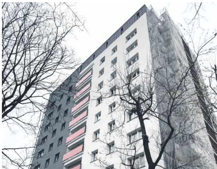
Efekty termomodernizacji wieżowca przy Szkolnej 10 robią wrażenie
