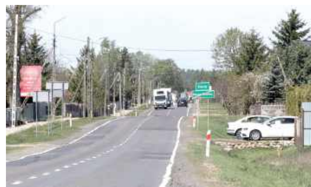
Prace na DK 63 mają rozpocząć się na przełomie czerwca i lipca i potrwać do jesieni
