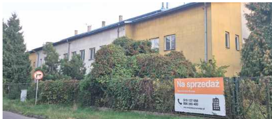
W planach inwestora jest m.in. nadbudowa, dzięki czemu budynek będzie posiadał cztery kondygnacje
