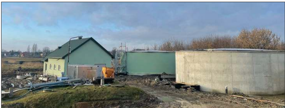
Nowa, rozbudowana oczyszczalnia pracuje do ponad miesiąca. Czekają na oficjalne otwarcie. Na zdjęciu obiekt w trakcie prac – styczeń 2023 r.
