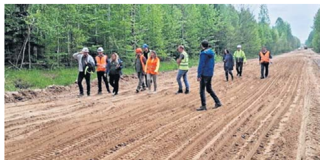
Na wniosek aktywistów na budowanej drodze odbyła się wizja terenowa przeprowadzona przez RDOŚ
