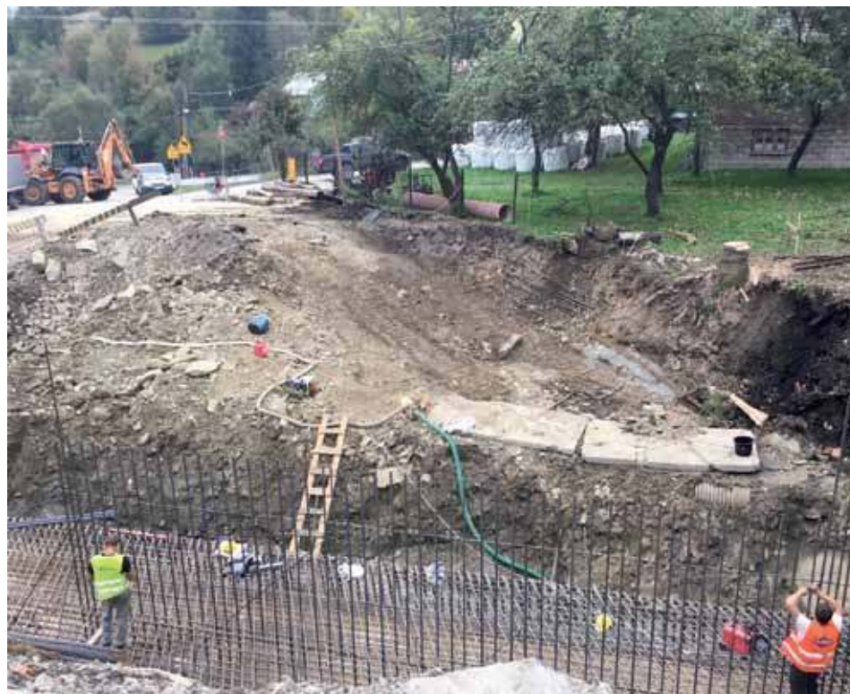
Roboty przy budowie mostu na Rdzawce idą pełną parą.
