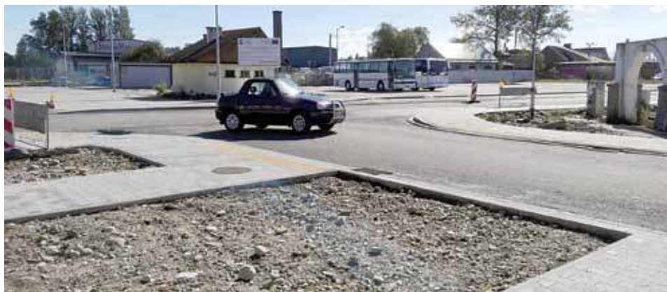
Wylot ul. Ogrodowej do obwodnicy będzie wąski.
