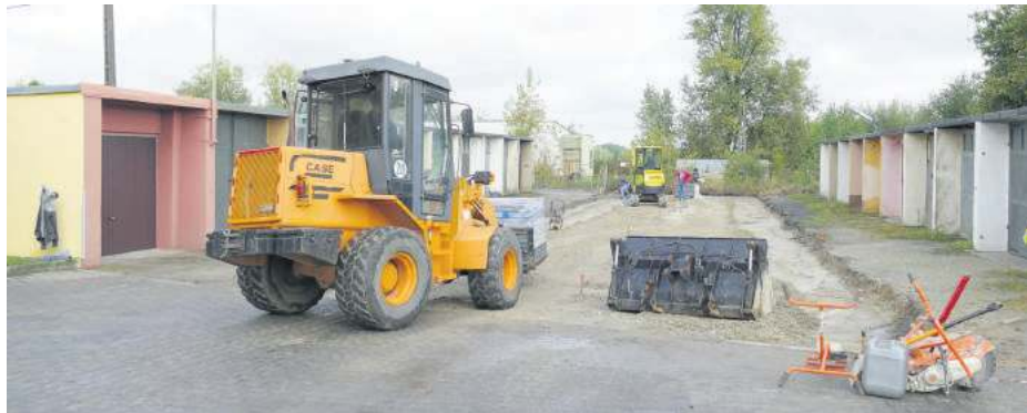
Prace przebiegały szybko i sprawnie
