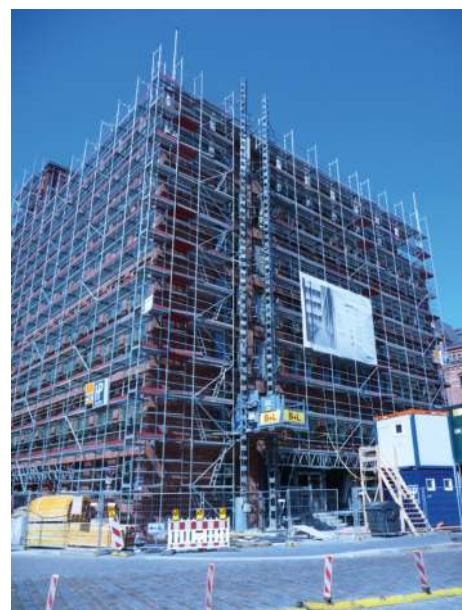
Fot. 2. Dźwig towarowo-osobowy GEDA 1500 Z/ZP
