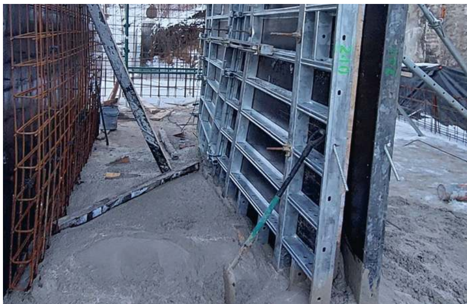
Fot. 2. Jedną z najczęstszych przyczyn awarii deskowania ściennego jest użycie ściągów o nieodpowiedniej nośności
