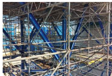
Fot. 2. Fragment rusztowania modułowego do modernizacji i wymiany kanału spalin między absorberem a kominem w Zakładach Azotowych w Puławach, pokazujący zastosowanie siatek bezpieczeństwa oraz dźwigarów kratowych
