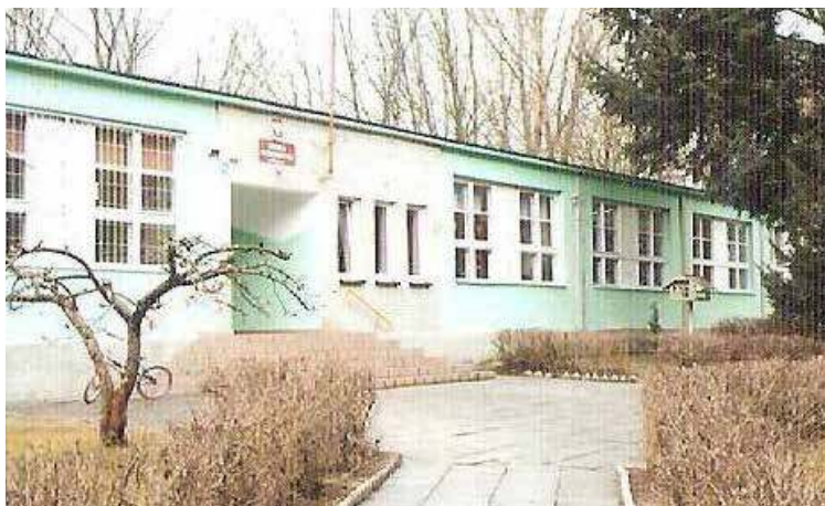
SP w Długolece już niedługo zostanie przeprowadzona inwestycja za ponad 100 tys. zł
