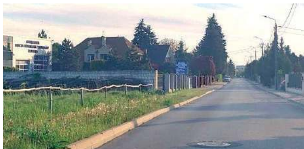
Na ulicy Świętochowskiego po jednej stronie brakuje odcinka chodnika. Na razie nie będzie dokończony
