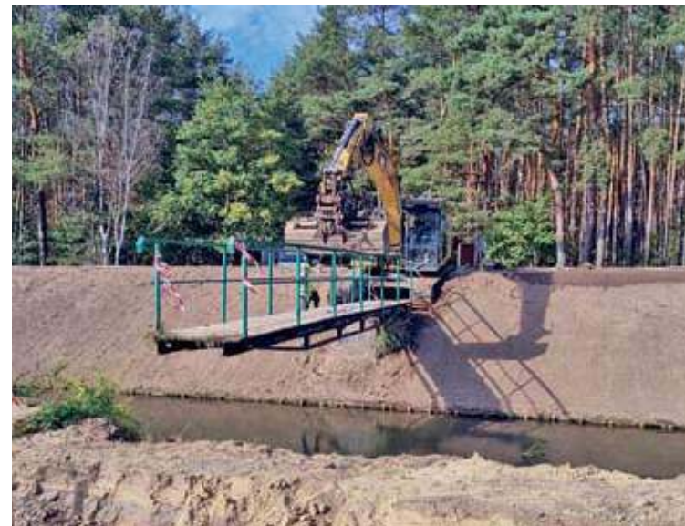
Kładka nad Czarną Strugą została zdemontowana w ubiegły czwartek (fot. UM Nowa Sól)
