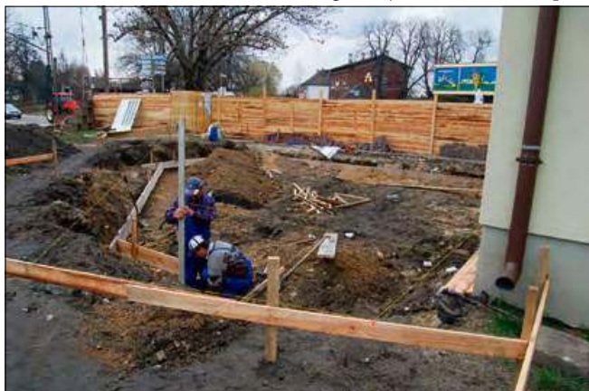
Wytyczanie granic nowego biura, budowa.
