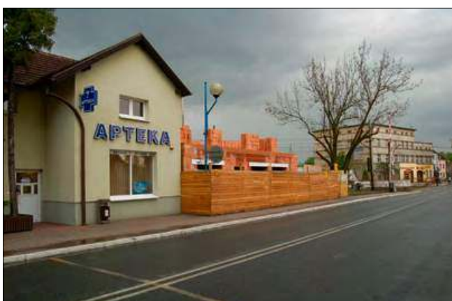
Budowa nowego biura w Gogolinie.
