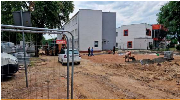
Przebudowa parkingu przy przychodni ma przynajmniej częściowo rozwiązać parkingowe problemy mieszkańców ul. Środkowej i ul. Niepodległości
