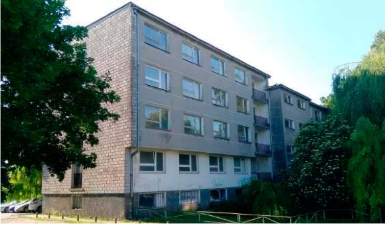
Zdaniem władz uczelni najbardziej sensownym rozwiązaniem będzie rozbiórka budynków, co ma nastąpić jeszcze w tym kwartale
