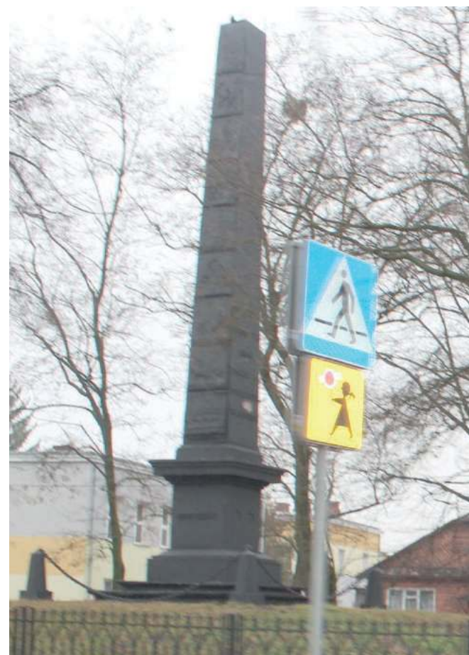
Pomnik Traktu Brzeskiego. Wykonawca ma ustalić przyczyny osiadania pomnika, zdemonstrować część tablic, schodów i płaskorzeźb oraz je odnowić
