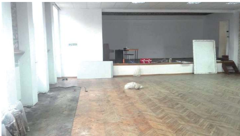
Remont Gminnego Ośrodka Kultury obejmie większą część budynku. Prace rozpoczęły się od zerwania starego parkietu w sali widowiskowej, zniszczonego po kilkudziesięciu latach użytkowania
