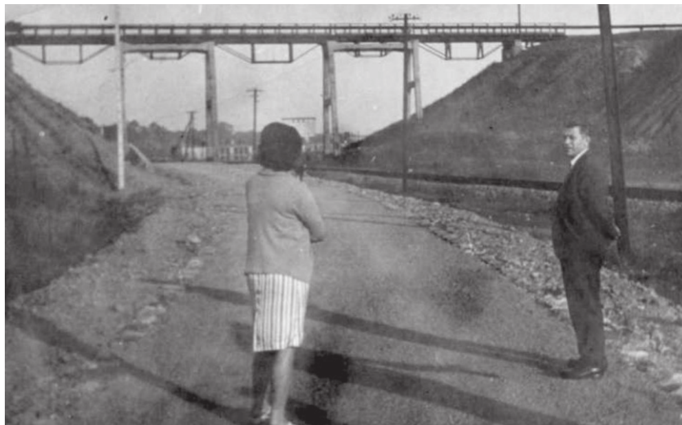
Most, którym transportowano kopalniany odpad na hałdę. Dzisiaj ul. Leśna na osiedlu Kąty
