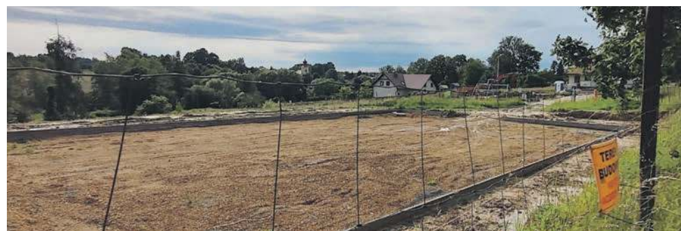
Budowa centrum rekreacyjnego w Porębie Żegoty
