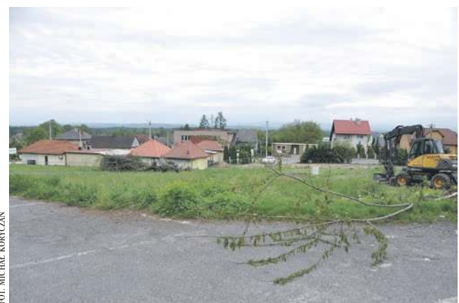
Trwa zagospodarowanie terenu przy placu Mogielnickiego
