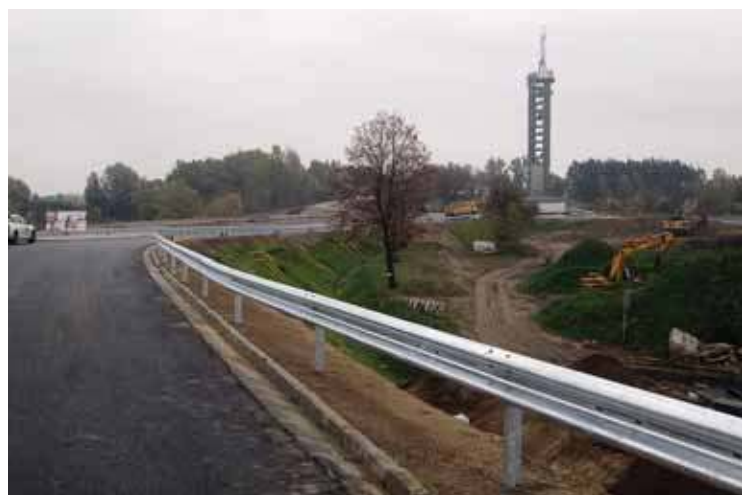
Widok na wieżę z wiaduktu budowanego węzła komunikacyjnego w okolicach Mławy
